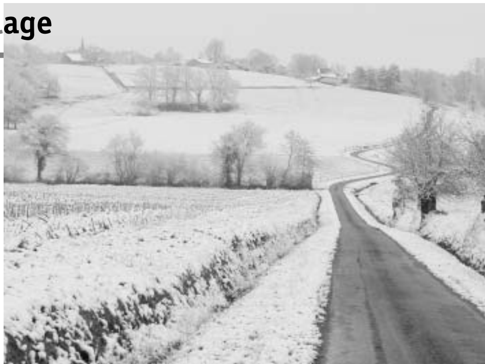
Cette photo est assez mal choisie pour montrer l'état de délabrement de notre voirie à Bonnut. En effet, si vous reconnaissez l'endroit, il faudrait aussi reconnaître que cette route a été refaite et qu'elle est en parfait état.
