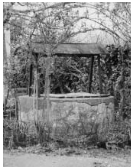
Le puits de Cassouret.
